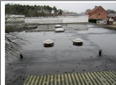
Foto 7: Dak kantoor vanaf woning
