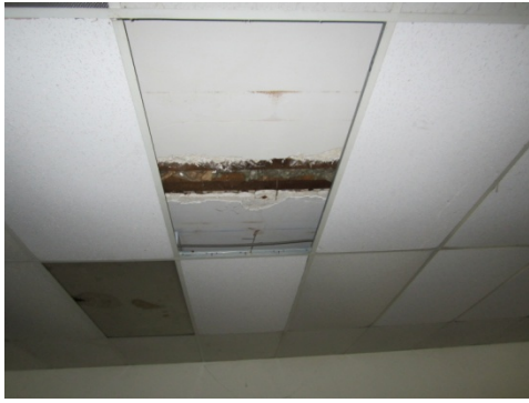
Foto 11: Plafondafwerking in zaal (gipsplaat + vals plafond)
