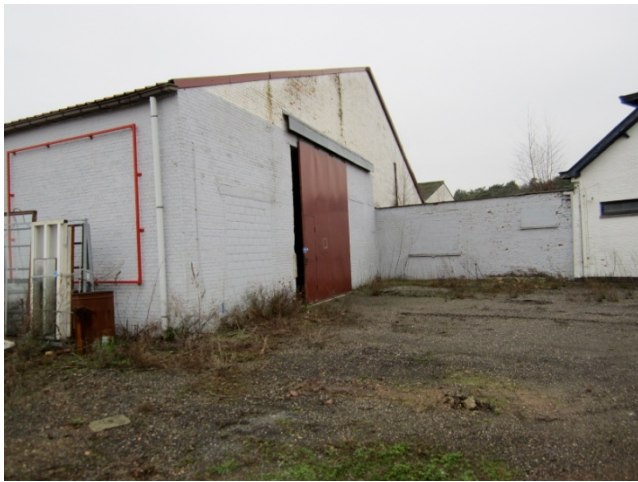
Foto 1: Loods A en doorgang naar woning
